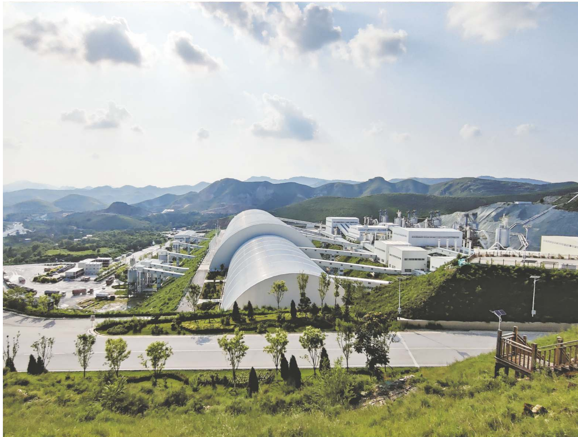
5000吨/小时 骨料线” 5000 т / ч заполнительная линия
